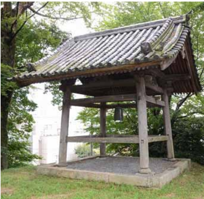
八幡宮社鐘楼 全景
