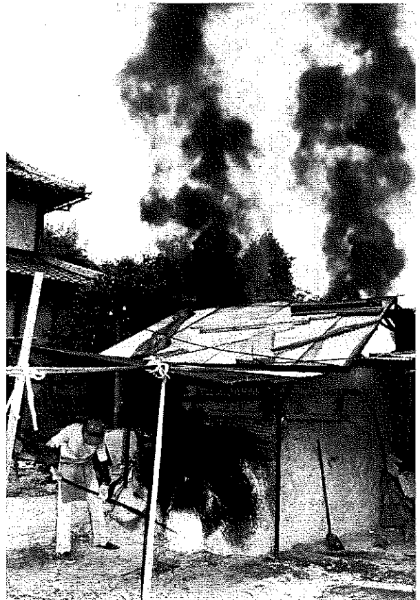
焼成のようす 浦田製瓦店 (写真：京都府立山城郷土資料館提供)
