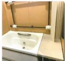
介護用の浴室。板を移動させることで左右に浴槽が移動します。引き戸で使いやすい。
