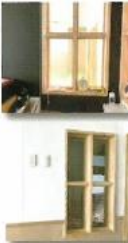
スタッフの宿舎の両側に小窓があり、両側の部屋を確認することができます。確認にドアを開けなくて良いので、子供達を起こさなくて済みますね!
