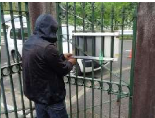
雨の中の「説明板」の取り付け2
