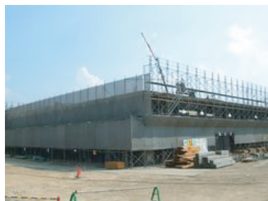
平成22年6月3日（木） 校舎・工事の様子
