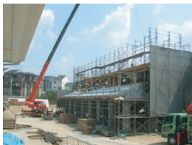
平成22年6月3日（木） 校舎・工事の様子
