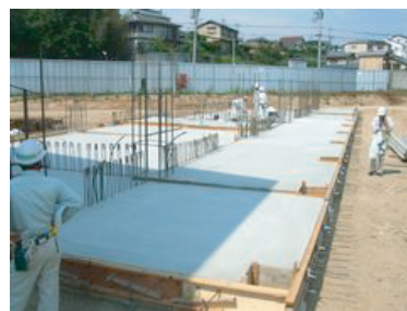
平成22年6月3日（木） 作業学習棟・工事の様子
