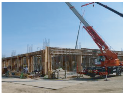
平成22年4月21日（水） 校舎・工事の様子
