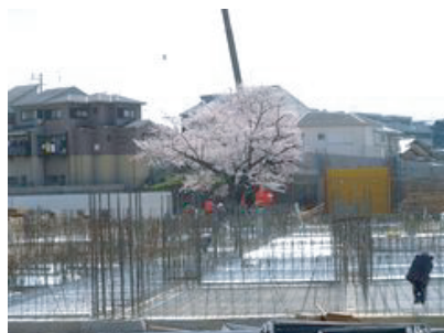
平成22年4月6日（火） 校舎・工事の様子
