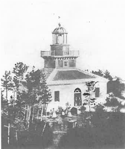
（初代）観音崎灯台 明治元年11月1日起工
