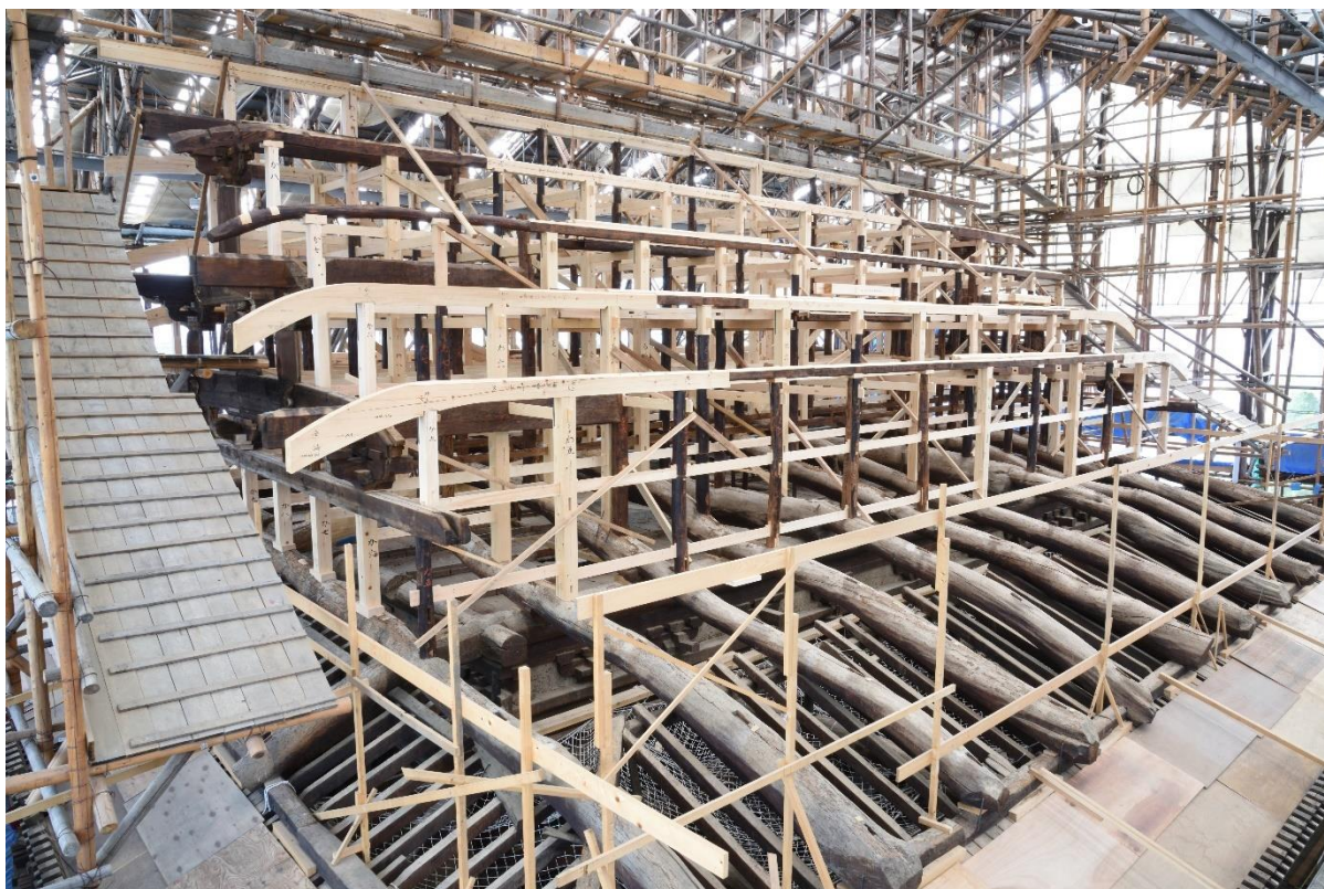
本隆寺 本堂 小屋組の様子
