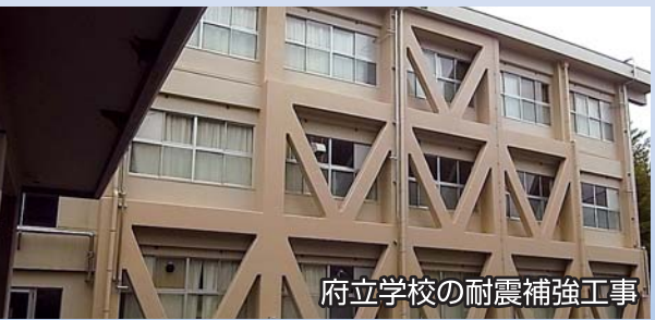
府立学校の耐震補強工事
