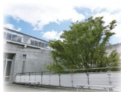
校舎と体育館をつなぐブリッジテラス
