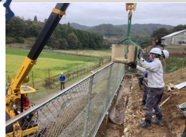
水路改修施工実習
