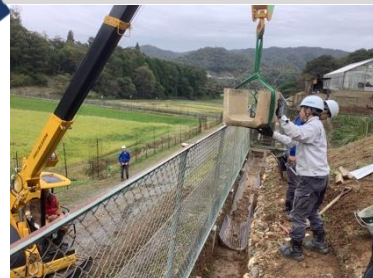
水路改修施工実習
