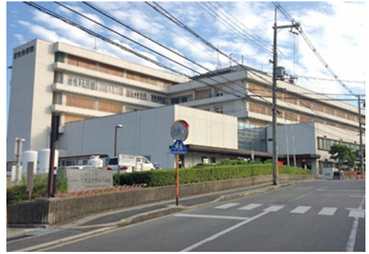
【仮設校舎(旧済生会京都府病院)の外観】
