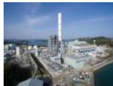
火力発電所（広島県大崎上島町）
