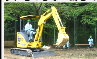
小型建機を操作する様子
