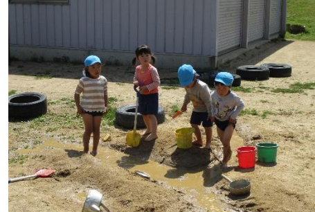
川の工事です。水をたくさん運ばなくてはならないので大変です。
