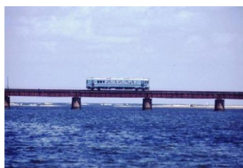
(京都丹後鉄道由良川橋梁)
