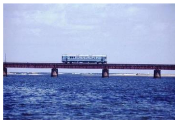
(京丹後鉄道由良川橋梁)
