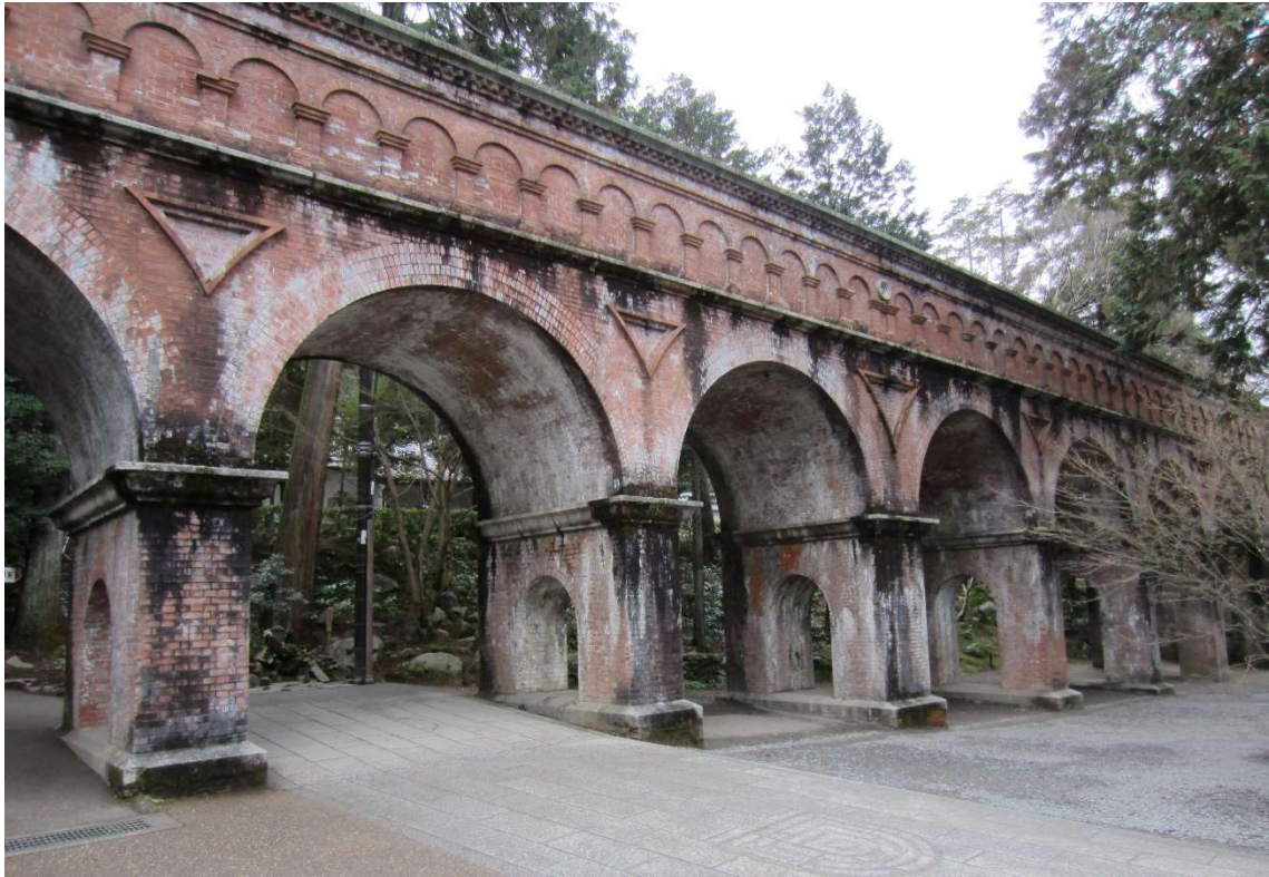
国宝 琵琶湖疏水施設 南禅寺水路閣（京都市提供）
