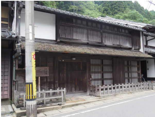
瀧澤家住宅 修理前 外観
