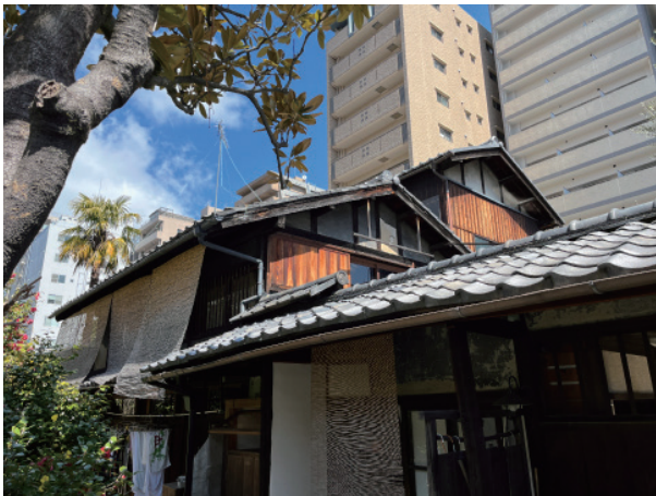
杉本家住宅旧漬物小屋 修理前 外観
