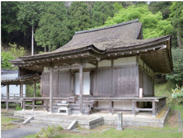
本願寺本堂 修理前 外観
