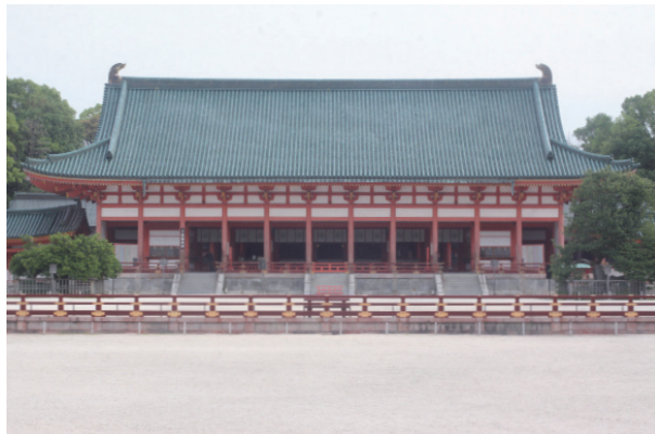
平安神宮大極殿 修理前 外観
