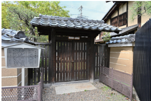
壬生寺大念仏堂附脇門 修理前 外観
