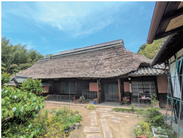
伊佐家住宅主屋 修理前 外観
