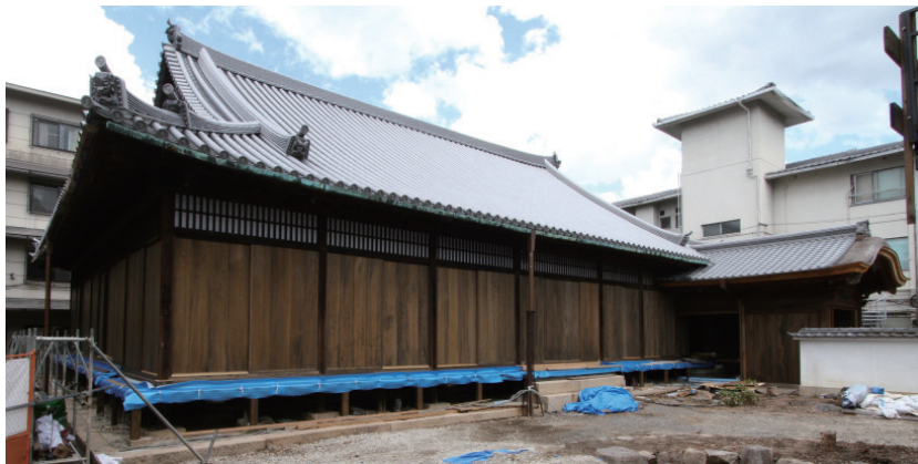
本堂 外観（完成間近の状況）
