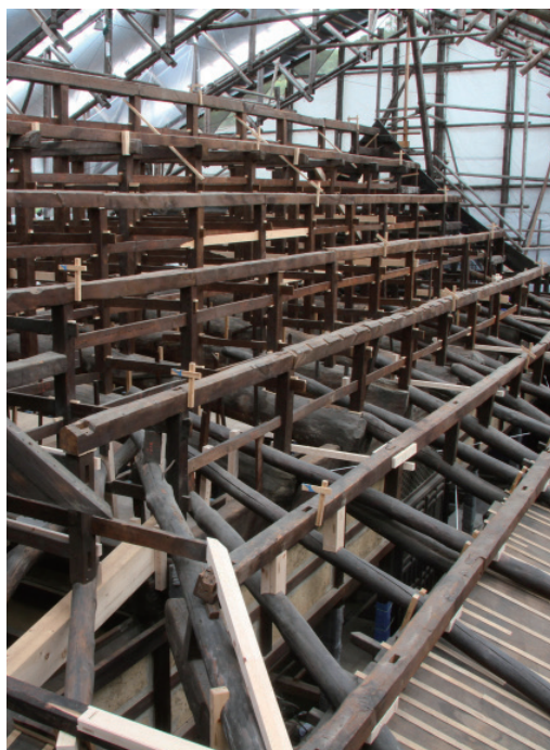
本堂 小屋組立中の状況
