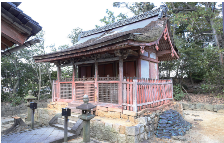
本殿 修理前 外観
