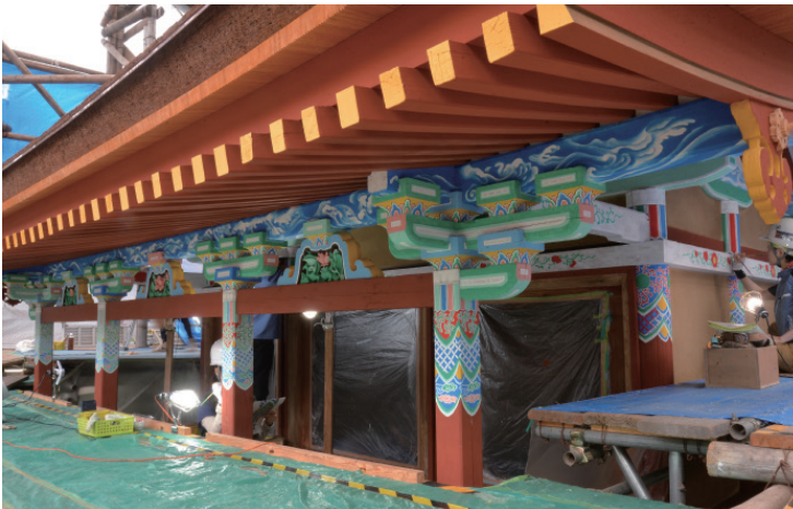
本殿 修理中 彩色施工中の様子
