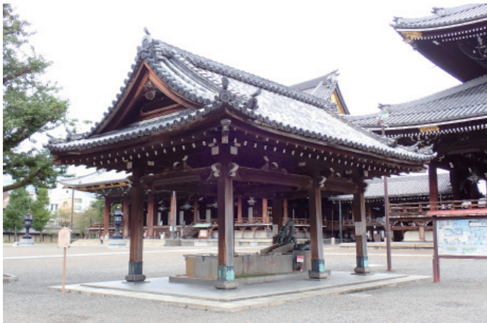
手水屋形 修理前 全景
