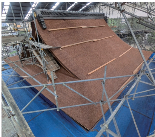
鐘楼 屋根全景
