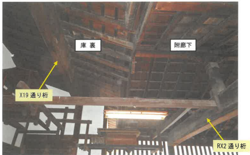
庫裏—庫裏附廊下接続部 軒裏の状況
