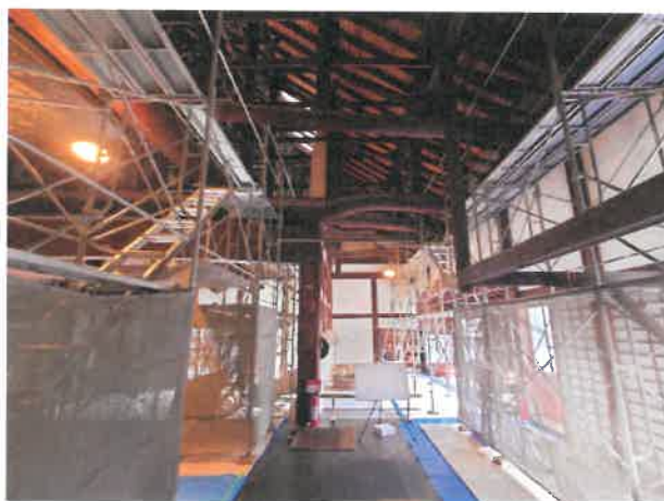
大庫裏・土間・大釜戸足場
