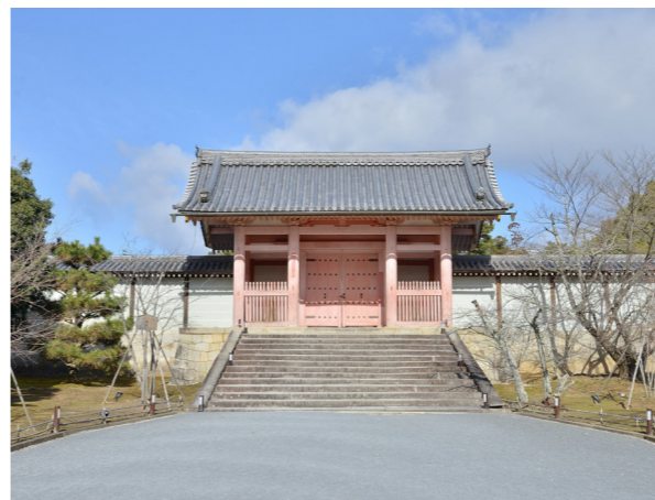
仁和寺中門 修理前 外観
