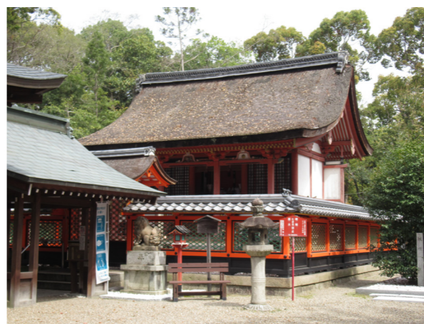
荒見神社本殿 修理前 外観
