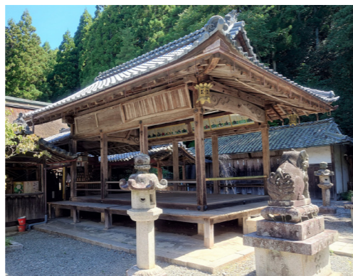
生身天満宮 拝殿 平成19年府登録 南丹市 屋根葺替(桧瓦葺) 江戸時代 天保2年(1831)
