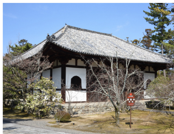
広隆寺講堂 修理前 外観
