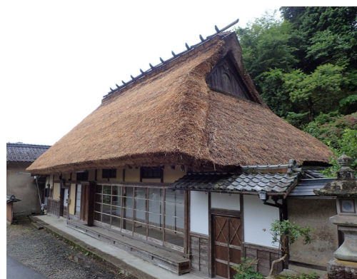
荒木家住宅 平成15年府指定 舞鶴市 屋根葺替(茅葺) 江戸時代 明和2年(1765)
