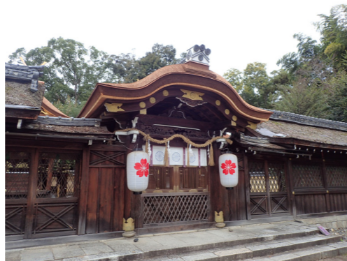
平野神社 中門 平成26年府登録 京都市北区 屋根葺替(檜皮葺) 江戸時代 前期頃
