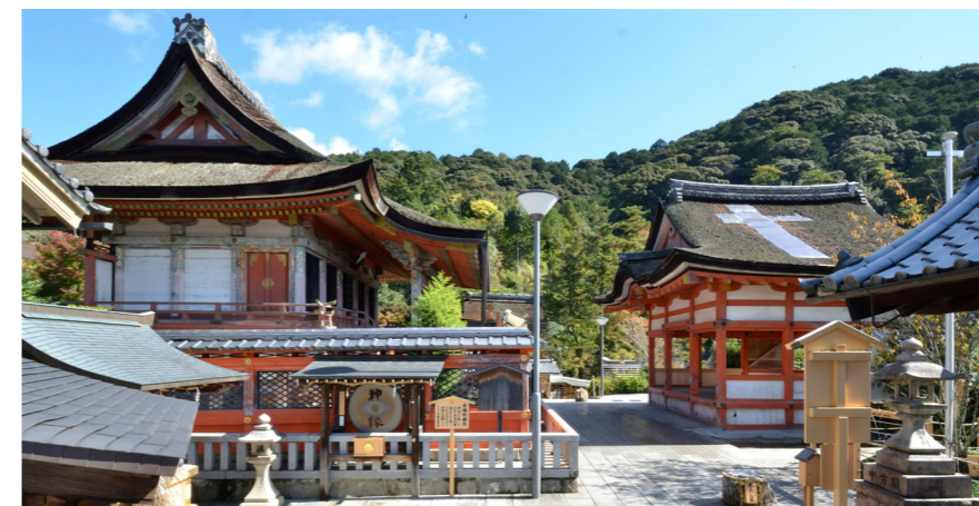
本殿及び拝殿 修理前 外観
