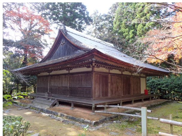
神護寺大師堂 修理前 外観
