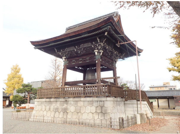
東本願寺鐘楼 修理前 外観
