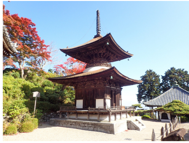
善峰寺多宝塔 修理前 外観
