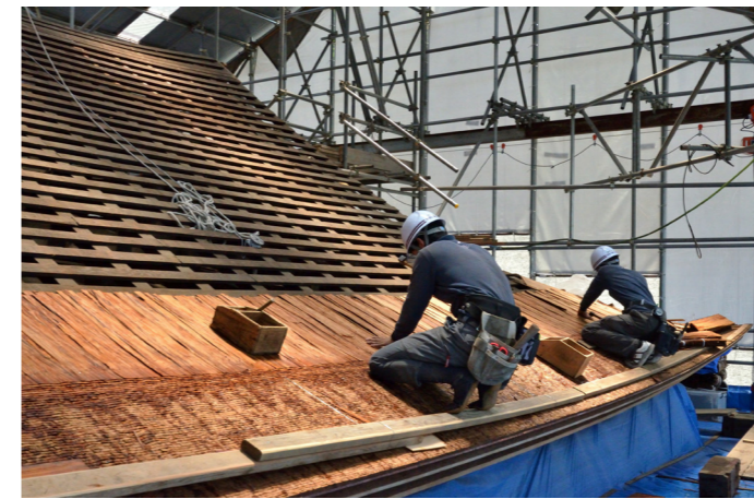
拝殿 檜皮葺施工の様子
