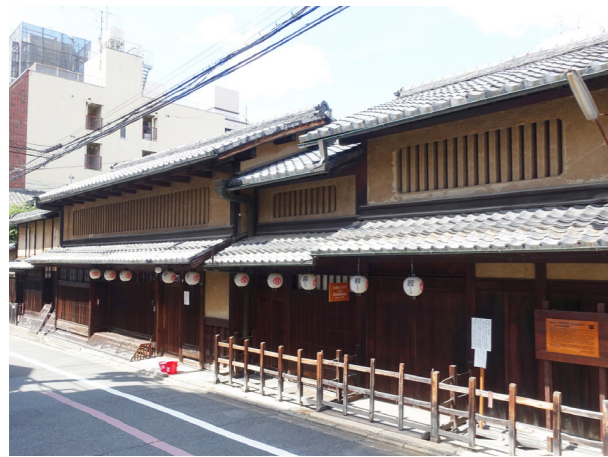
杉本家住宅 修理前 外観
