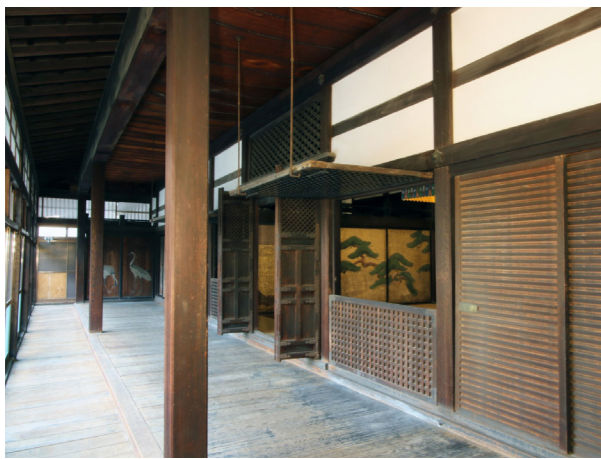
本堂 修理前 内部広縁
