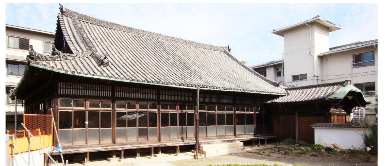
本堂 修理前 外観
