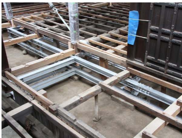
本堂 床下での耐震補強の状況
