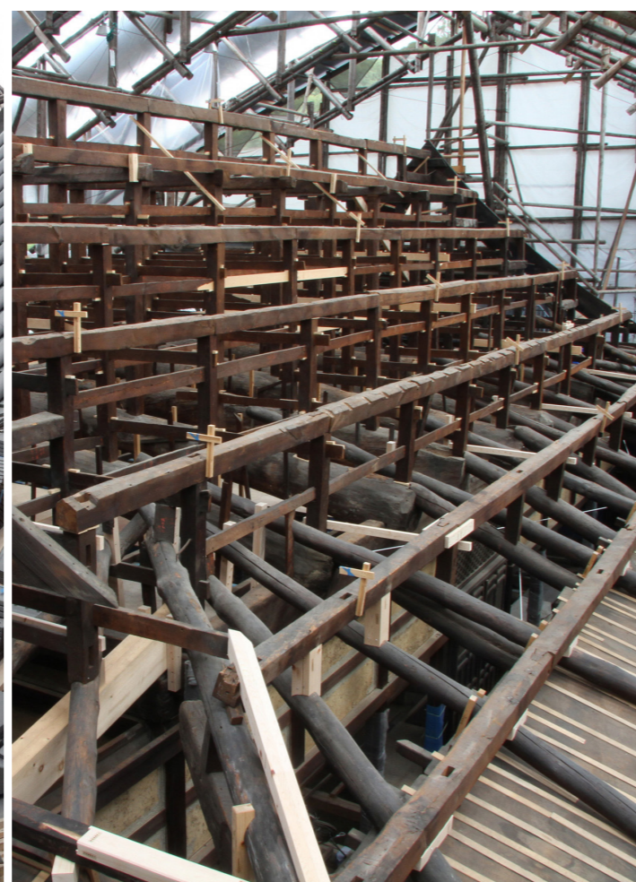
本堂 小屋組み立て中の状況
