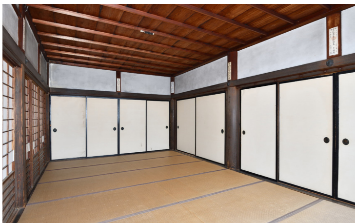
塔司寮(書院) 修理前 衆会間
