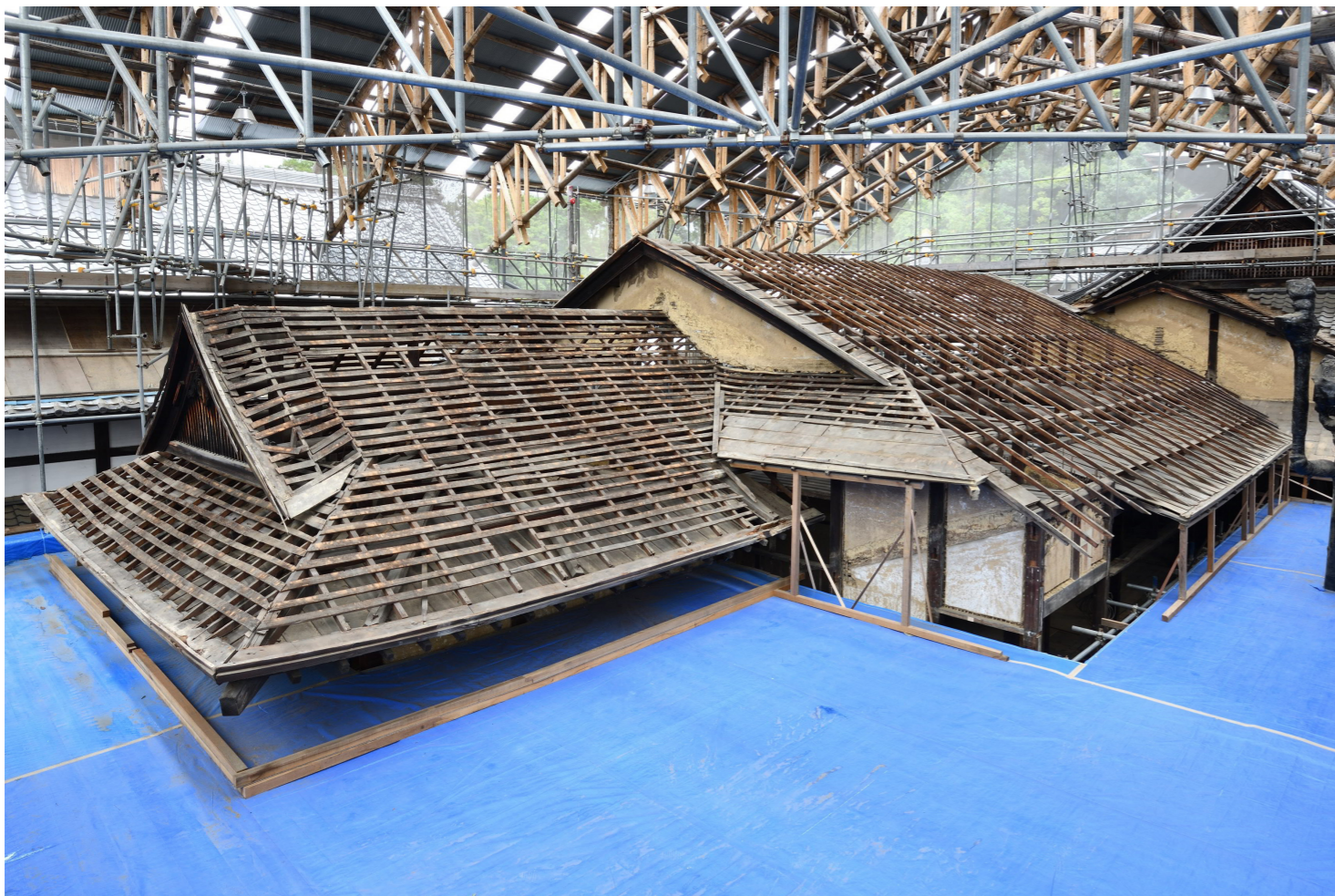
塔司寮(書院) 屋根解体中の状況
