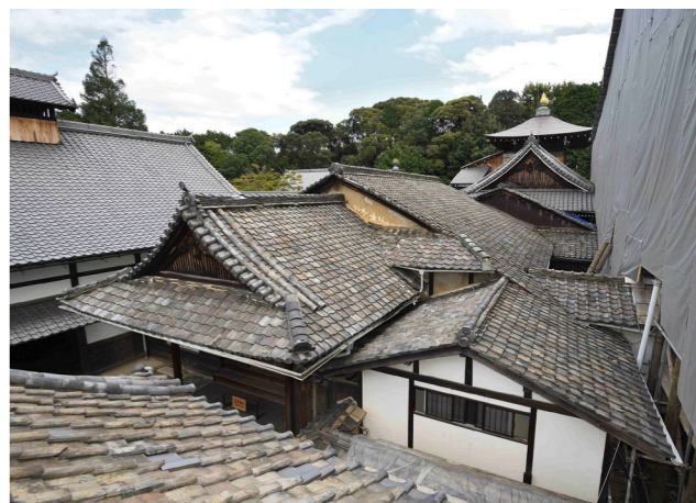
塔司寮(書院) 修理前 外観(西より)
