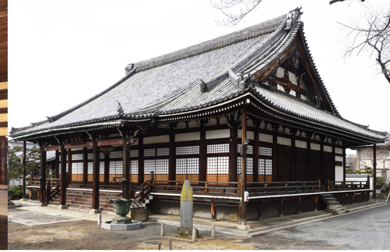
本堂 修理前 外観
