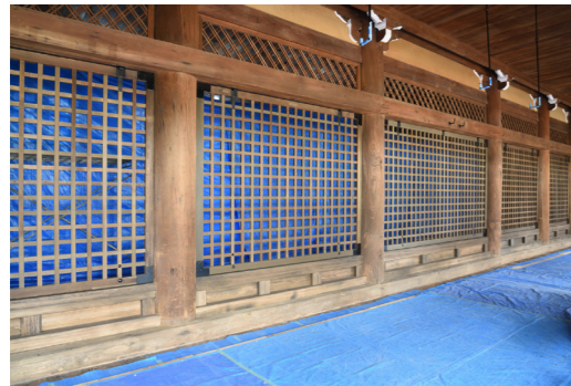
内陣外陣境部戸取付
