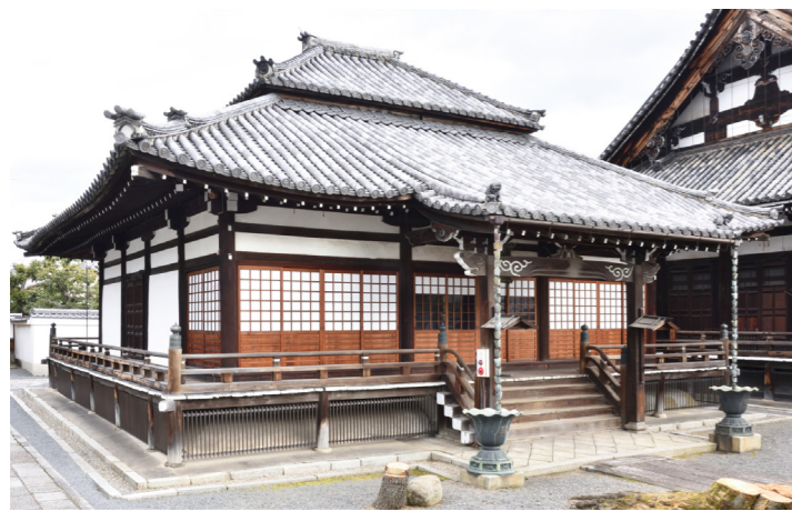
祖師堂 修理前 外観
