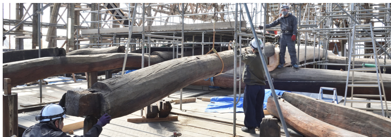
庫裏 梁組立中の状況
