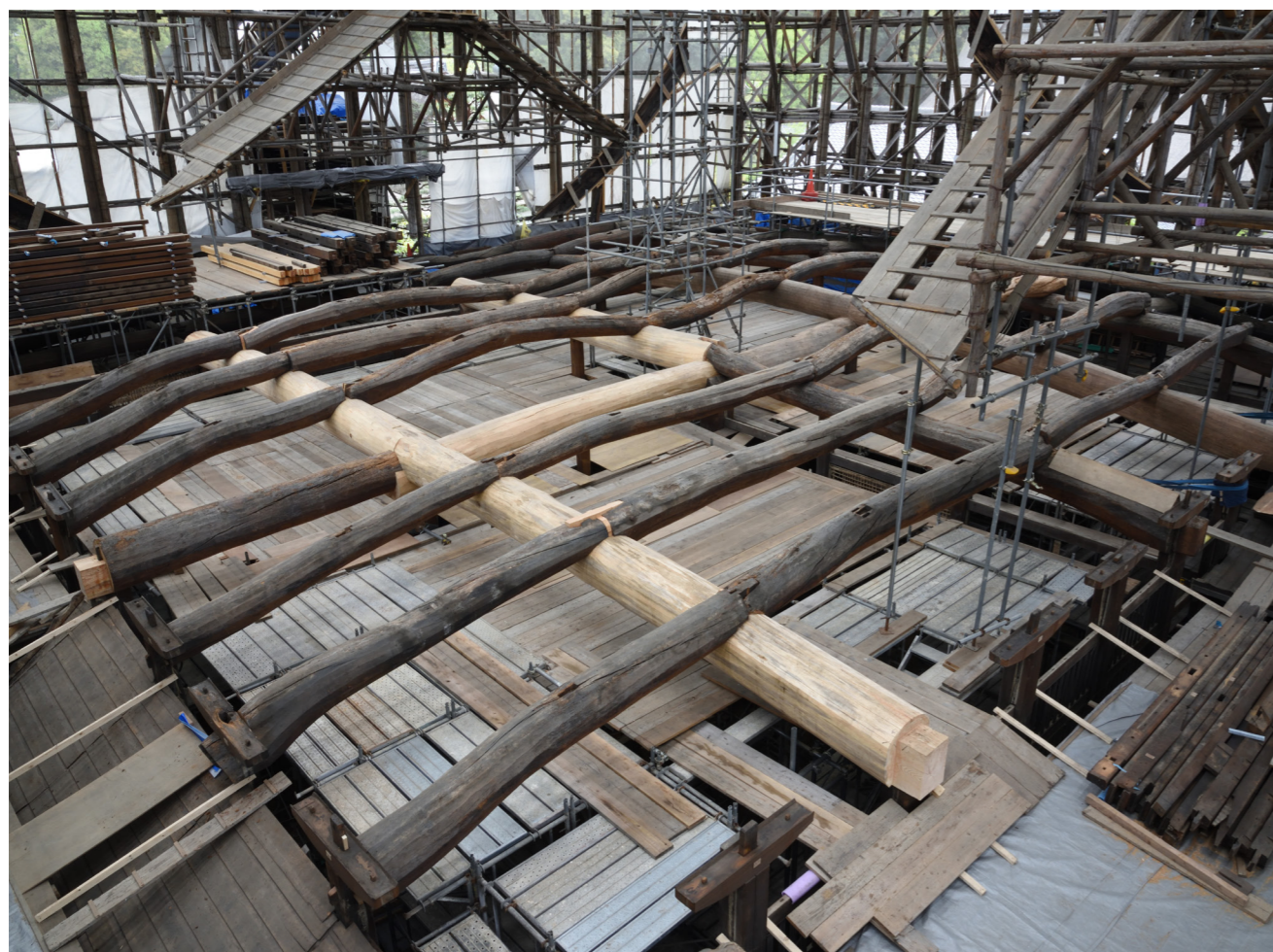
庫裏 梁組立完了の状況
