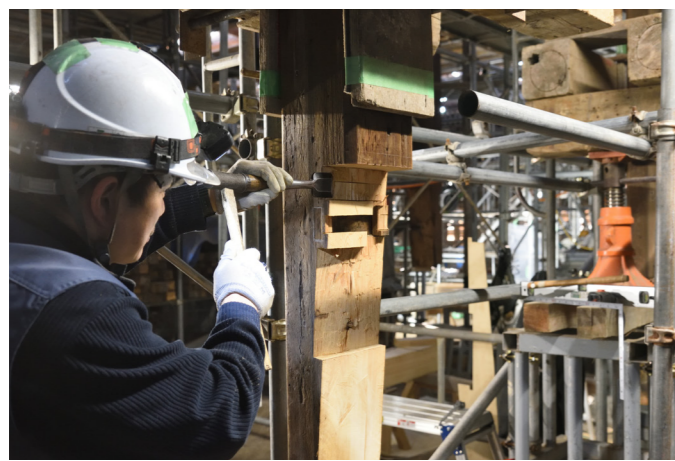
庫裏 柱根継加工状況
