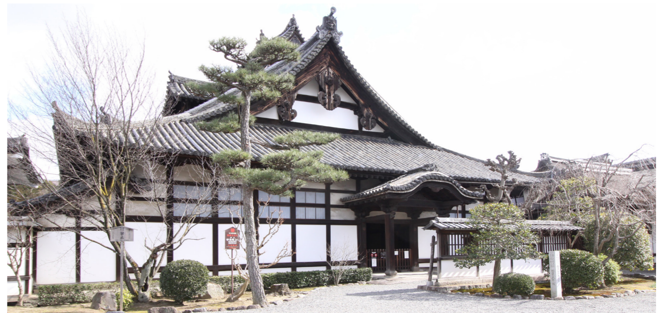
庫裏 修理前 外観
