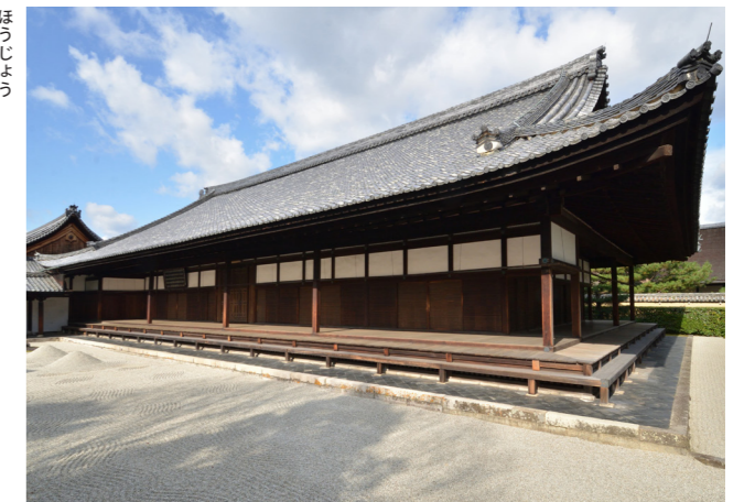
方丈 修理前 外観
