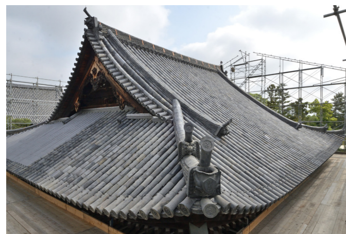
仏殿 屋根葺替完了の状況
