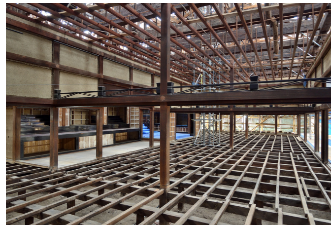
方丈 内部の解体状況
