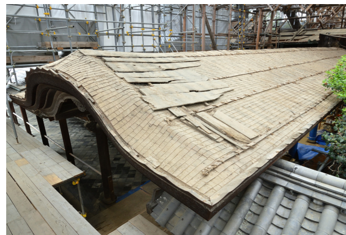
玄関 瓦を降ろした状況
