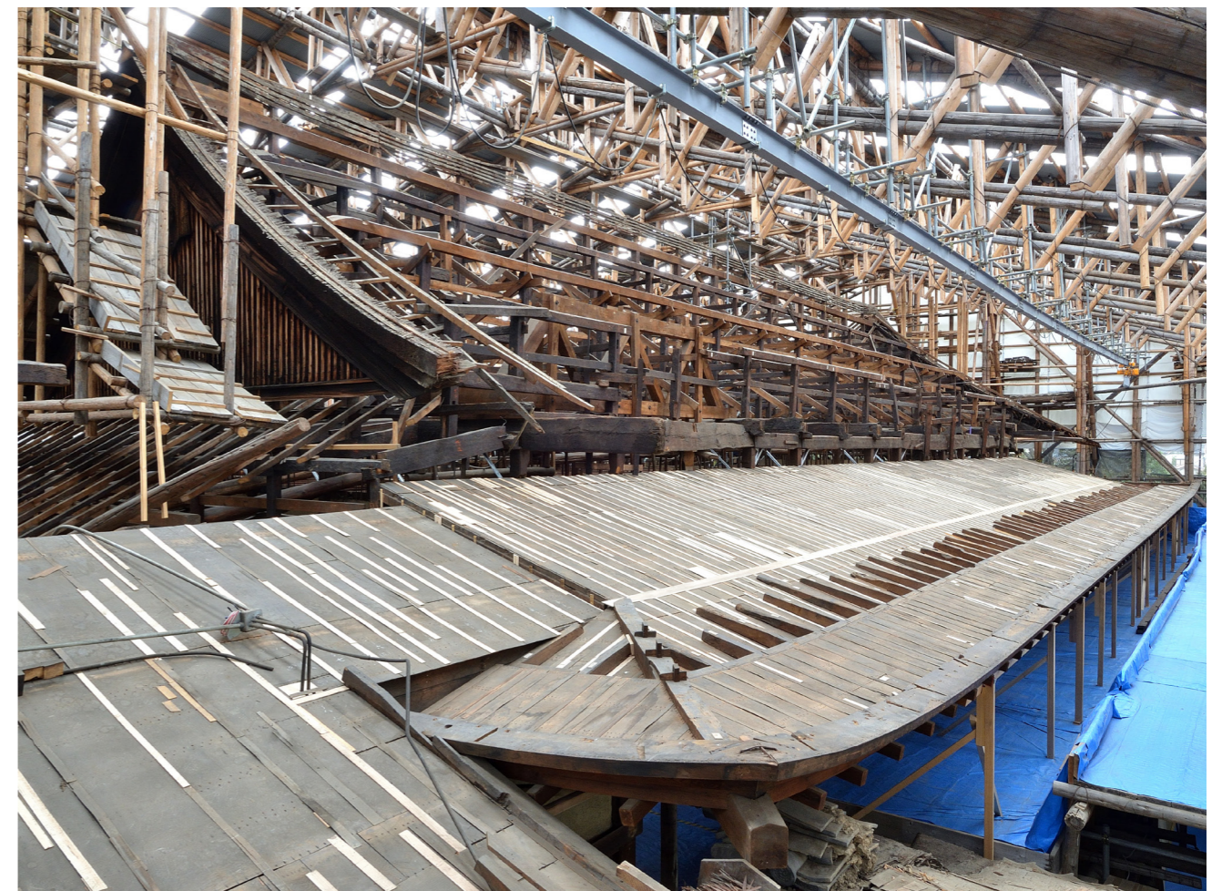
方丈 小屋組の組立状況
