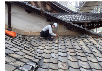
解体前の調査 (東福寺常楽庵塔司寮)
