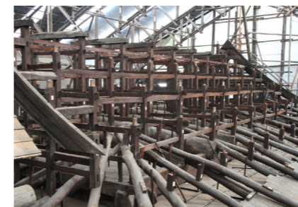
小屋組の解体 (良正院本堂)
