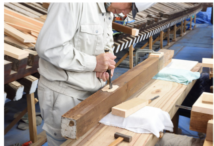
部材の補修 (本隆寺本堂)
