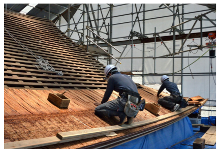
檜皮屋根葺き (地主神社拝殿)
