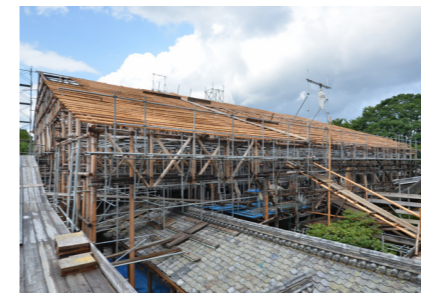
素屋根の建設 (大徳寺方丈)
