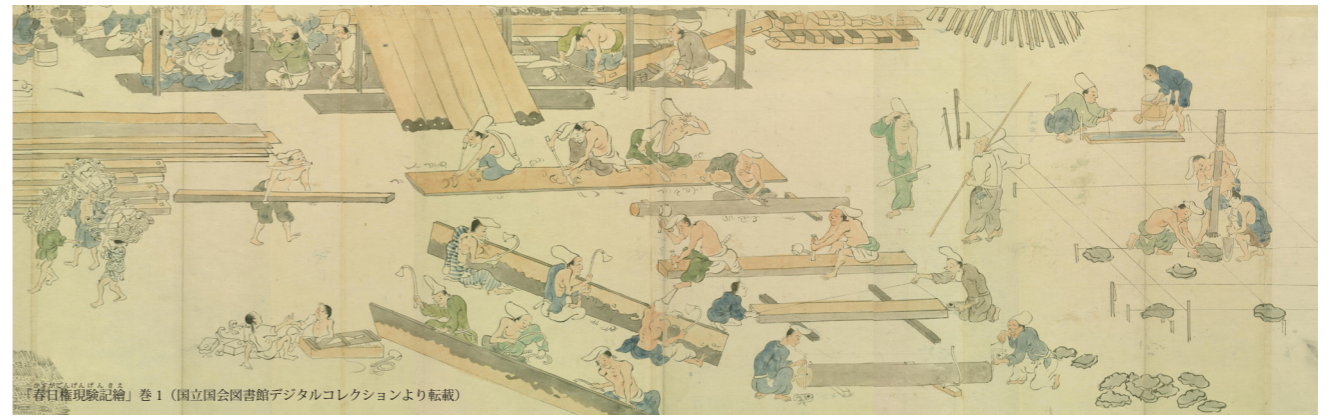
中世の建設工事の様子。鑿・槍鉋・手斧などを手に、工匠たちが活発に働いている。右側で長い棒を持っている人物は棟梁で、手にしているのは間竿と呼ばれる定規にあたるもの。左側には、子どもが手伝いをする様子も描かれている。
