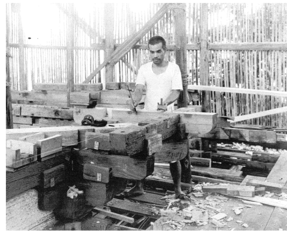
国宝光明寺二王門の部材の組立（昭和修理時）
