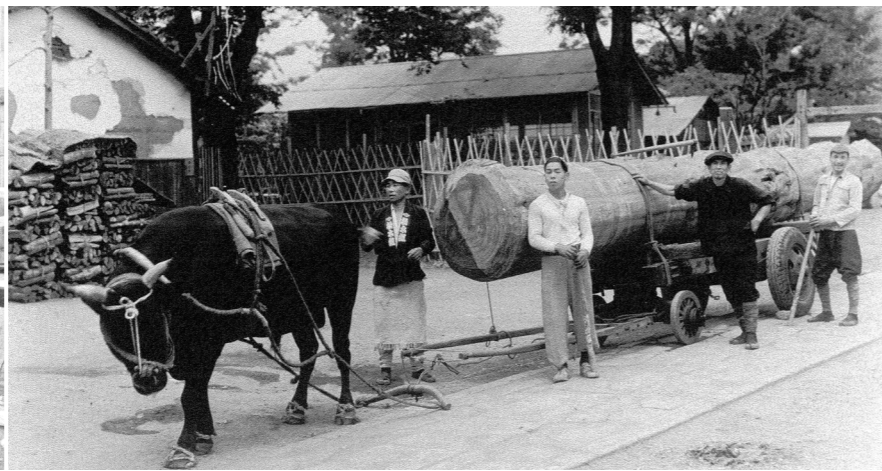
国宝大報恩寺本堂の部材の運搬（昭和修理時）
