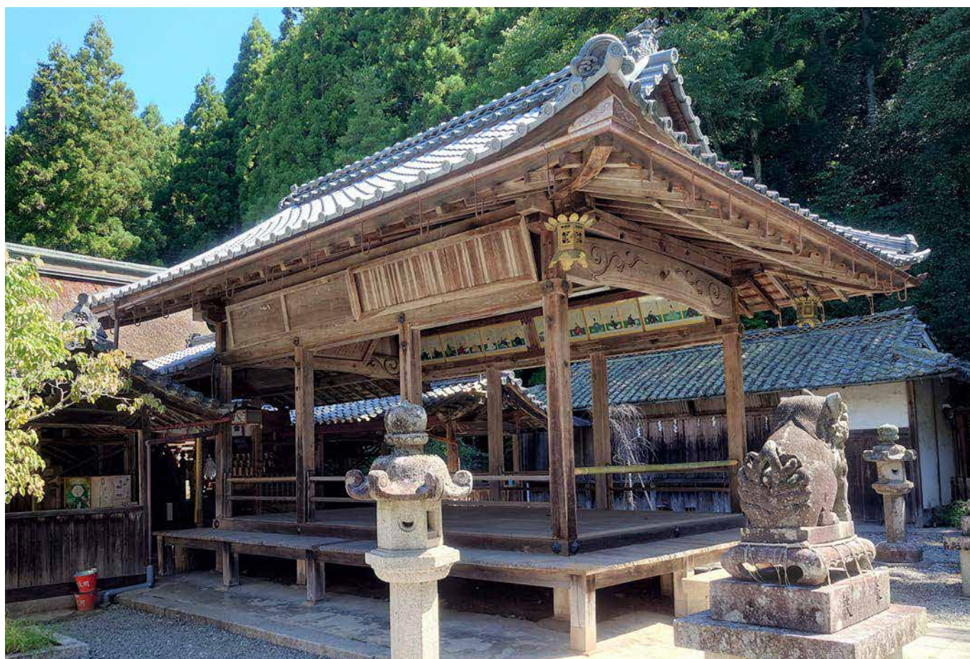
竣工した拜殿
