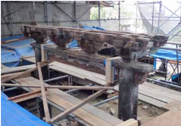
解体途中の様子
