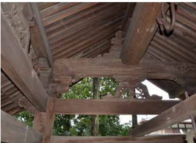
八幡宮社鐘楼 架構
