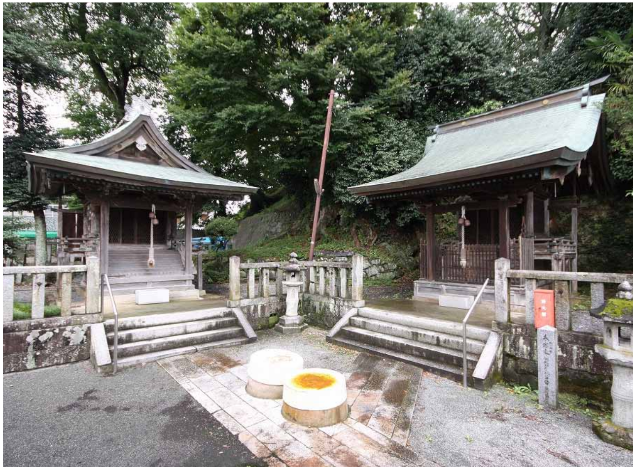
八幡宮社本殿（左）及び請田神社頓宮（右）
