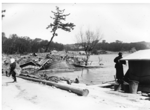
網野町小浜の道路陥没による浸水
