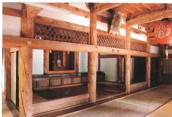
指定 金輪寺本堂 内部（亀岡市）
