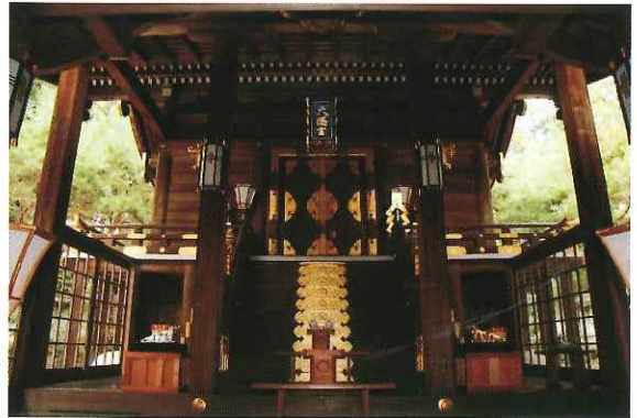
指定 長岡天満宮本殿 正面(長岡京市)
