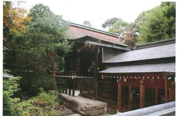
指定 長岡天満宮本殿 外観(長岡京市)
