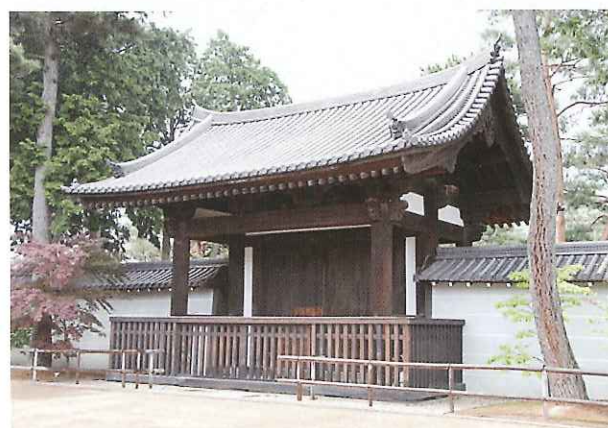
相国寺勅使門・総門防災施設事業（京都市上京区）
