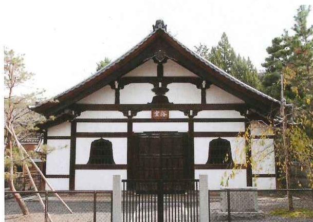
指定 建仁寺浴室 正面 (京都市東山区)
