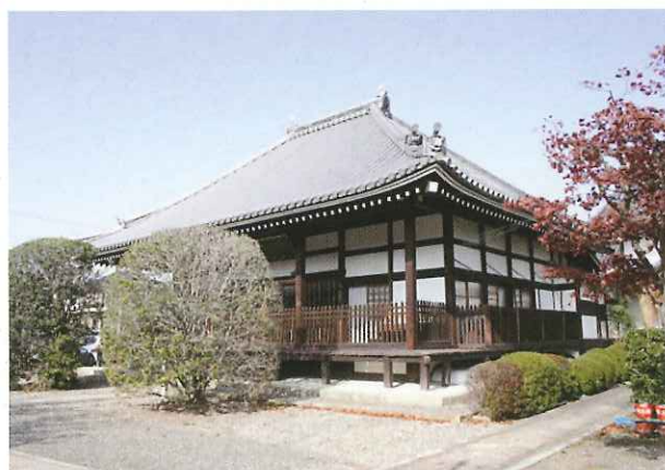
北真経寺本堂保存修理事業（向日市）
