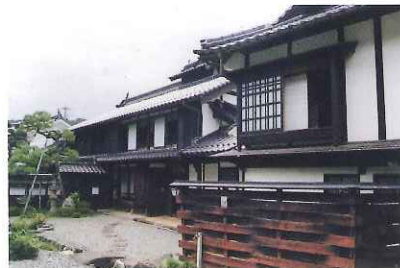
桐村家住宅主屋ほか2棟 (福知山市)
