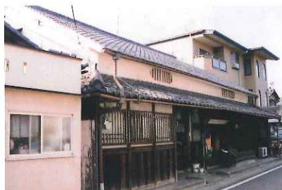
旧石田家住宅主屋 (長岡京市)
