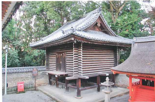
指定 石清水八幡宮 校倉（宝蔵） 外観 (八幡市)
