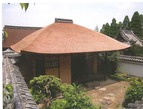
酬恩庵建造物保存修理事業
