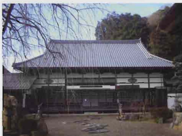
安国寺方丈保存修理事業
