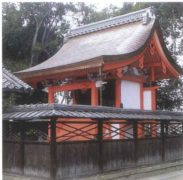
平井神社建造物保存修理事業
