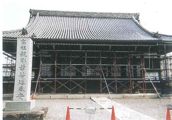
妙覚寺建造物防災施設設置事業（工事中）
