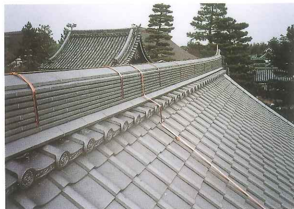
聖澤院建造物防災施設事業
