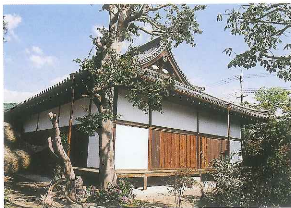
天真院建造物保存修理事業
